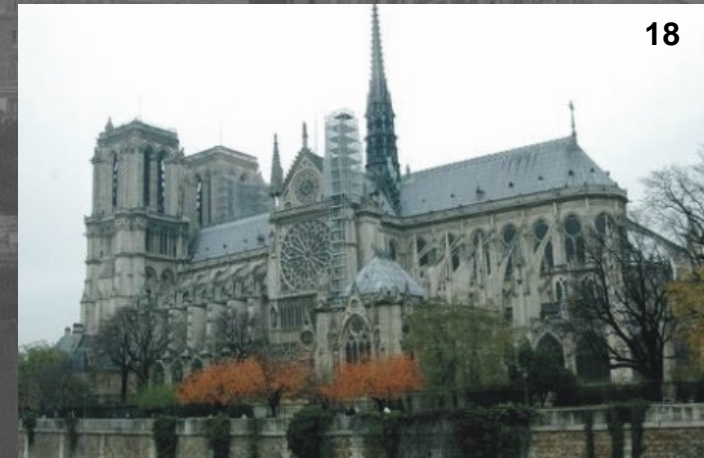
Figura 18 - Fachada norte. Fonte: GOMEDI (2004).
