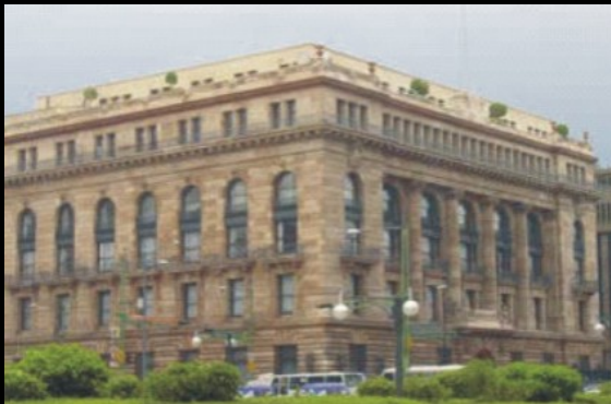
Figura 30 - Edifício Bancário do México. Fonte: Secretaria de turismo do governo do distrito federal do México.
