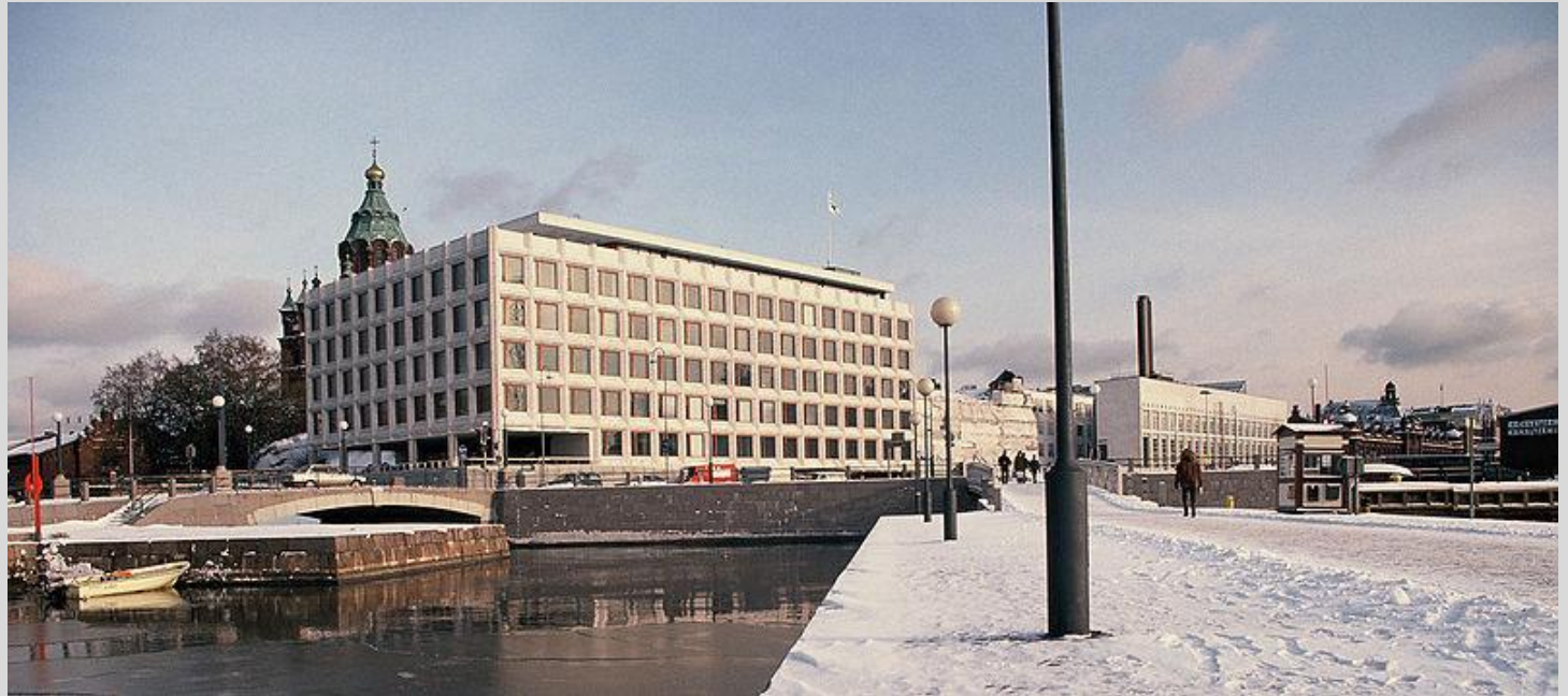
Figura 1: [Foto externa do edifício] Fonte: TTKK, 2006.
