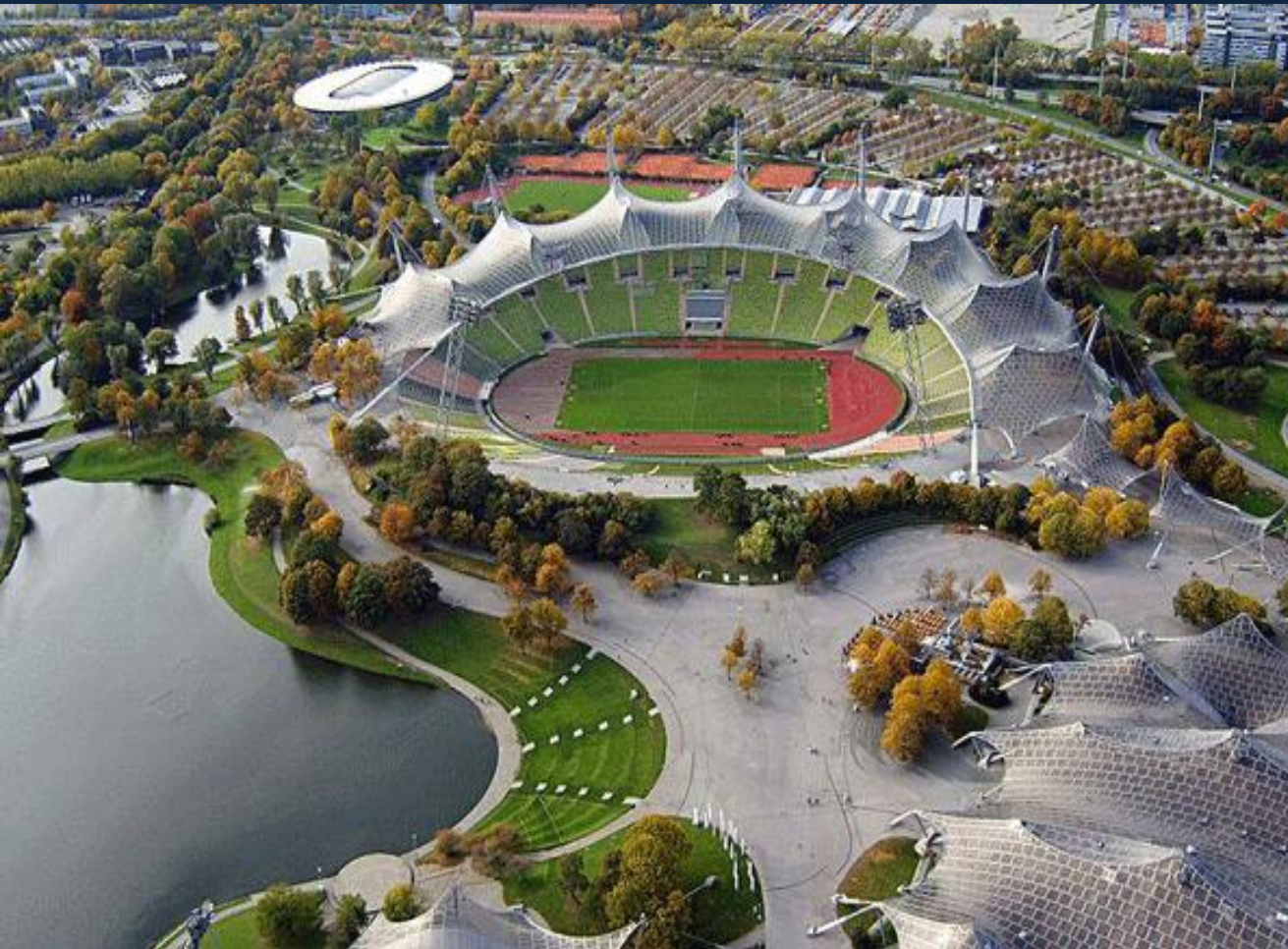
Figura 62: Estádio Olímpico de Munique, (1972) Arquiteto Frei Otto.
