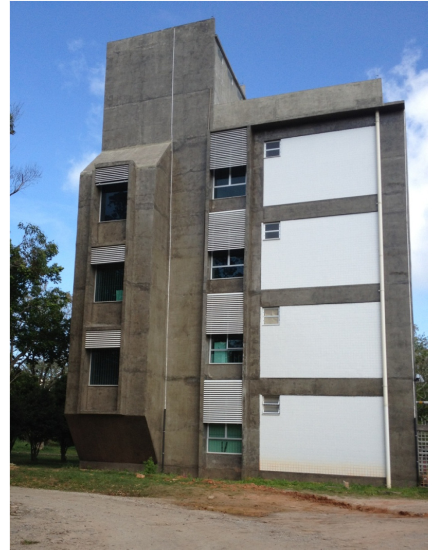
Figura 07: Fachada Lateral CEBIME (Leste)
