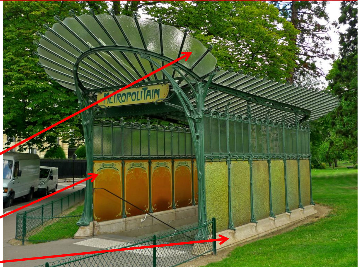
FIGURA 134: Entradas das estações de metrô, Paris (Final Séc. XIX – Início Séc. XX). FONTE: Sound Land Scapes
