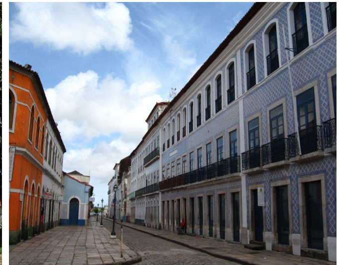
Figura 107: Sobrados azulejados em São Luís do Maranhão.
