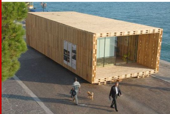
Figura 263: Casa de Pallets
