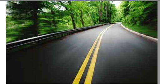
Figura 260: Pavimentação de Asfalto com Raspas de Borracha de Pneu
