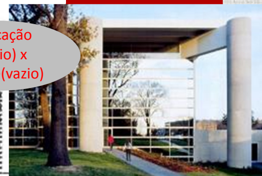
Figuras 119 e 120: Centro Power (Roche-Dinkeloo, 1965-71)
